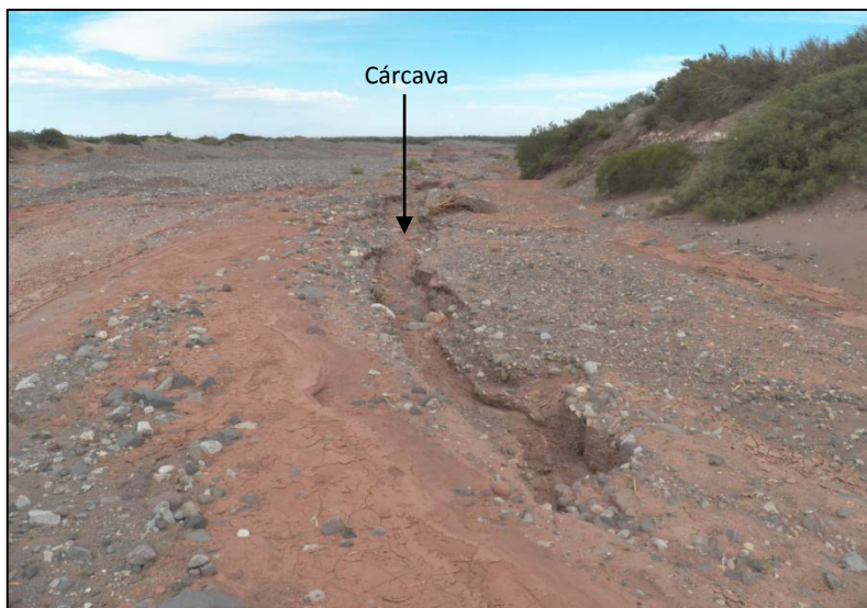
Foto 24: Se muestra la formación de cárcavas en fondo del lecho del arroyo
