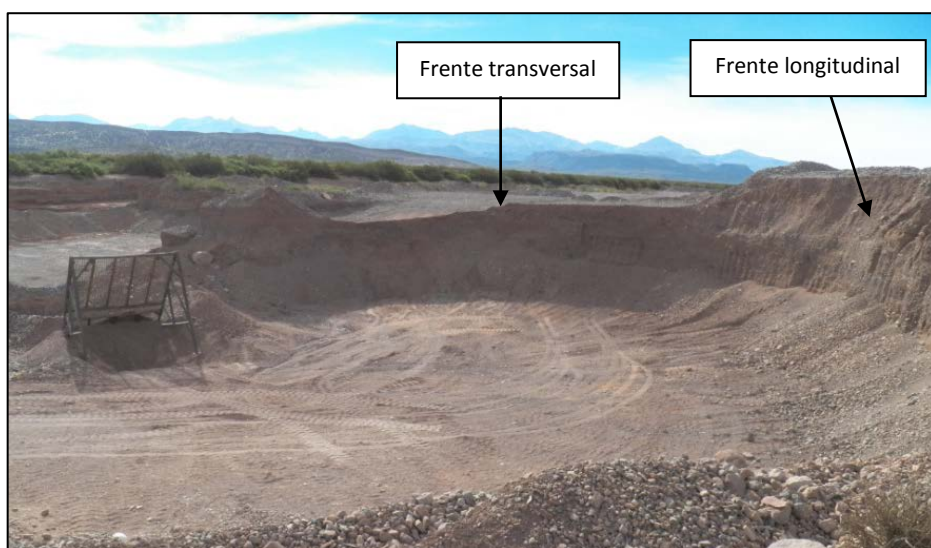
Foto 19: Frentes de excavación de Cantera
